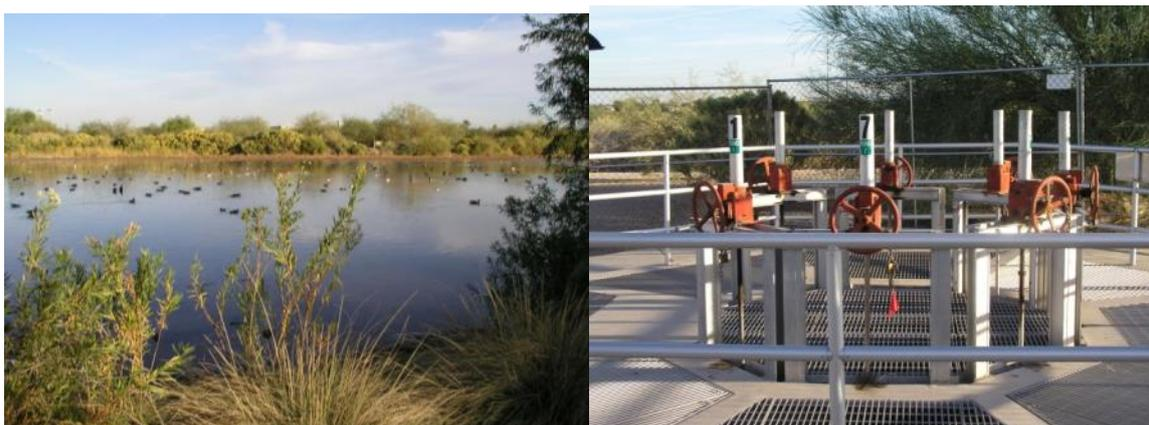
**Figura 7. Regeneración hídrica de un humedal mediante acciones de recarga artificial con pozos que alimentan su sustrato en las inmediaciones de Phoenix, Arizona.**
