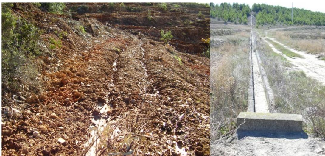
**Figura 16. Acciones mecánicas para minimizar la escorrentía, facilitar la recarga y la plantación posterior (izda.) y construcciones para canalizar y nivelar el exceso de agua de escorrentía (dcha.) Neila (CyL).**
