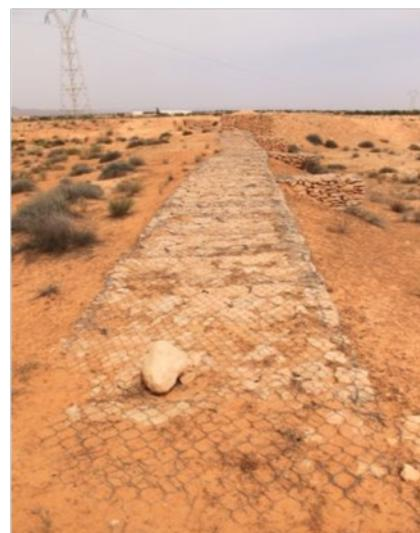
**Figura 15: Dique en cabecera de Cuenca para la retención e infiltración de aguas torrenciales en situación de avenida. Las Palmas (izda.), check dam en Zarzis, Túnez (dcha.).**
