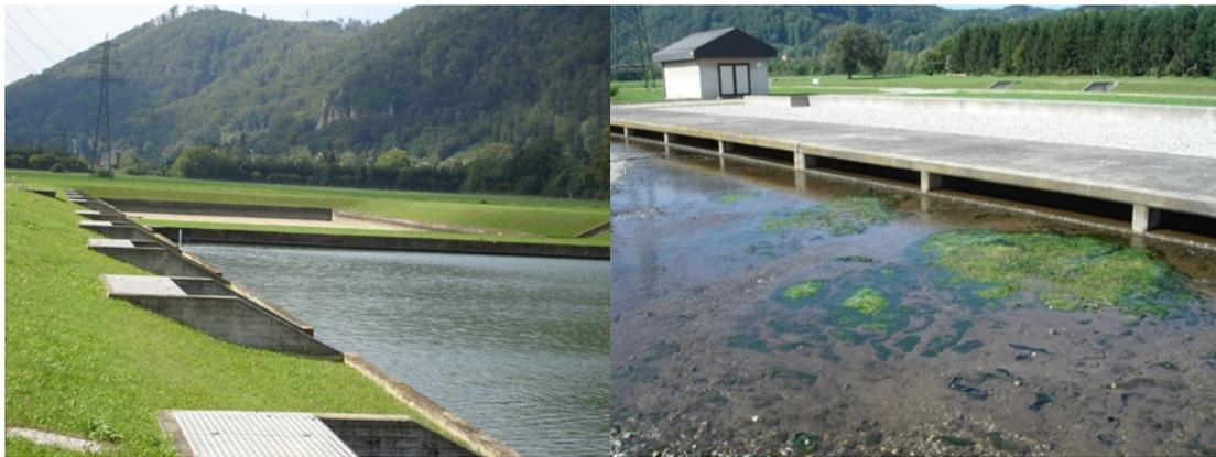
**Figura 4: Balsas de infiltración con aguas regeneradas de la depuradora de Graz, Austria.**
