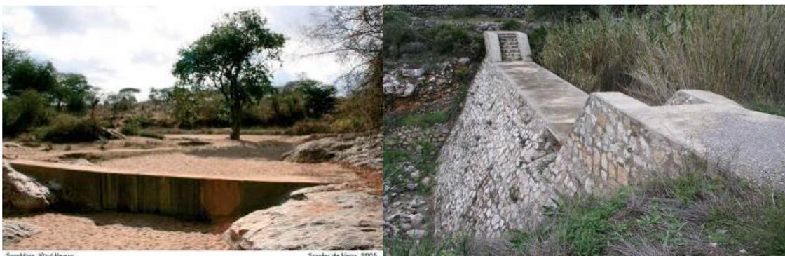
**Figura 3. Diques transversales para retener la escorrentía subterránea a través del subálveo de un cauce fluvial, como almacén para abastecimiento. La medida reduce además la temperatura del subsuelo del aluvión. Sand dam en Kenia (izda.) y dique de laminación y recarga en Alicante (dcha).**
